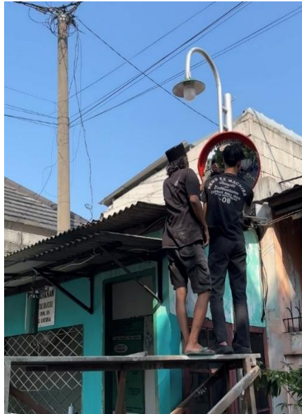
Gambar 2. Hasil akhir pemasangan kaca cembung
